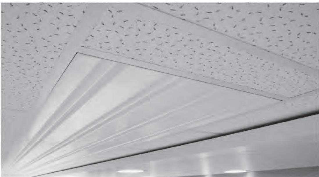
Durch den Einsatz von hochgezogenen Anschlusskästen werden alle Ansprüche an ein ästhetisches Deckenbild erfüllt. Diese Variante ermöglicht eine problemlose Integration in Rasterdecken.
